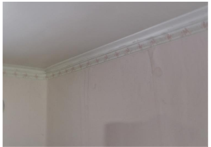
45-46. Päärakennuksen huonetilojen katto ja seinäpinnoissa vanhoja vuoto/valumajälkiä (kts em vesikatto/yläpohja)
