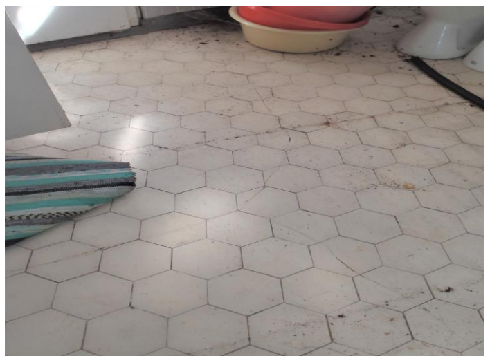
7-8. Lämmönjakohuoneen lattia kostea/kosteusjälkiä. Peh-wc:n lattian betonilaatassa hiushalkeamia
