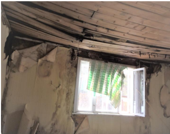
35-36. Pihapään huonetilan välipohja parven alla lahovikainen; ähes romahtamispisteessä. (kts seur)
