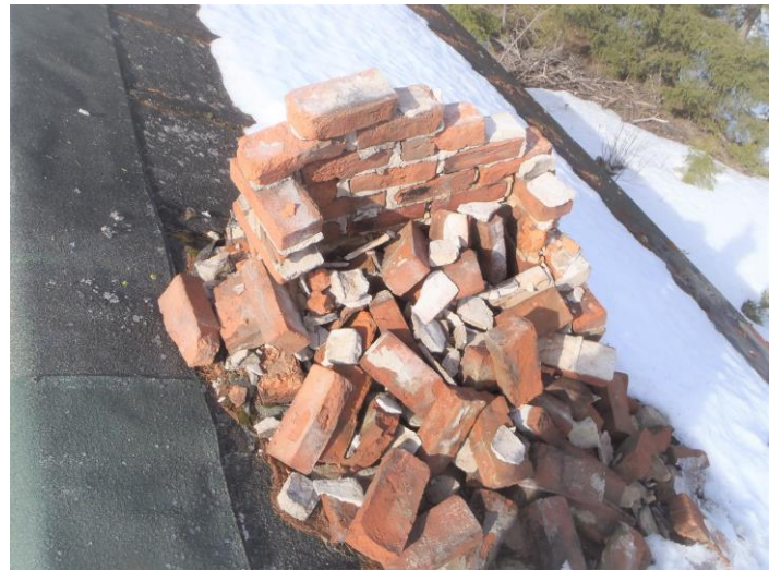
25-26.Vesikaton kattuhuopa heikkokuntoinen takalappeella(pihalappeella korjattu).Yksi piipuista romahtanut
