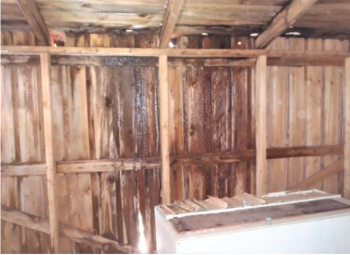
41-42. Talousrakennuksen lisävarastoissa katto vuotaa/vuotanut, välivaraston muhaeristeinen yläpohja romahtanut
