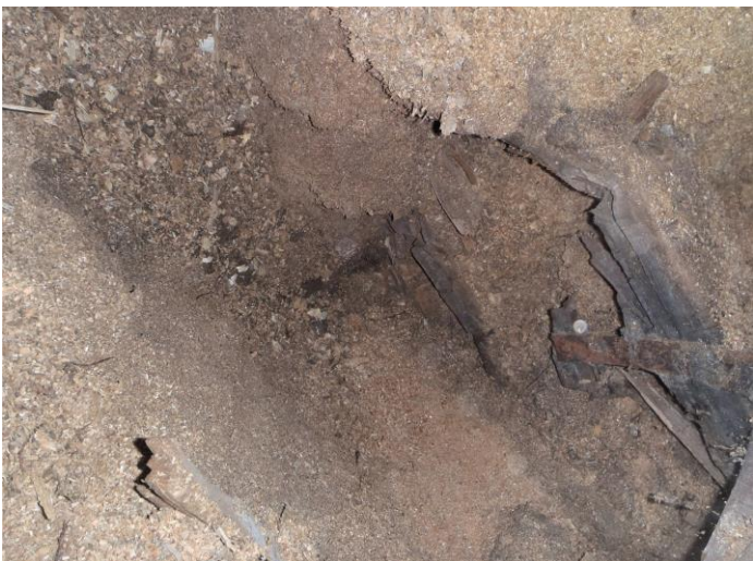
9-10. Ulkoseinäyläosissa/yläpohjassa pihisivulla (ent k/oh-et:n vuotkohdat) vanhoja kosteusvaurioita (kattohuopa uusittu)
