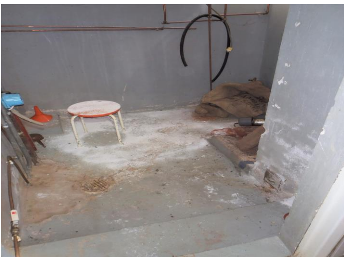
7-8. Lämmönjakohuoneen lattia kostea/kosteusjälkiä. Peh-wc:n lattian betonilaatassa hiushalkeamia
