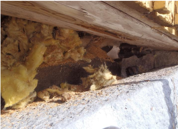
5-6. Pihisivulla keittiöseinällä alapohja pieneltä osin pudonnut, perustuskivi painunut. Piipujuuressa alapohjassa kost.jälkiä/-vikaa
