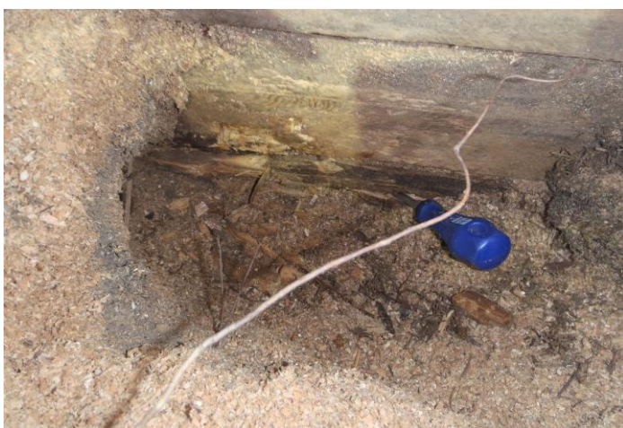
15-16.Yläpohjassa/em ulkoseinäyläosassa kuivuneita(katto korjattu) kosteusvauriokohtia pihasivulla keittiössä ja oh/et seinällä
