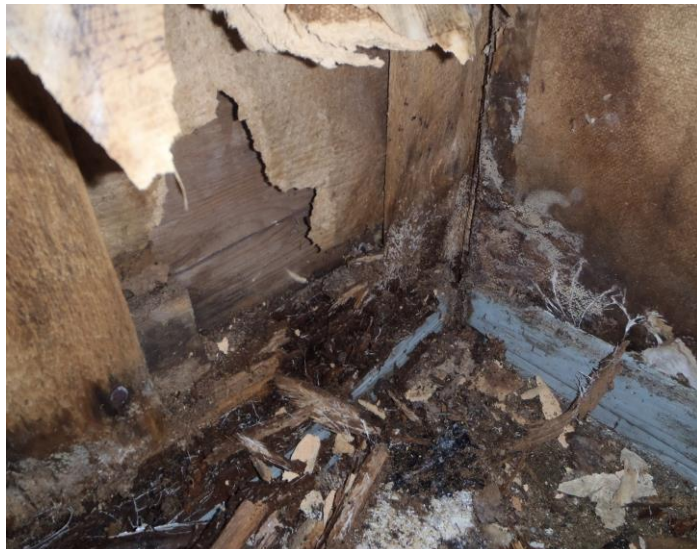
35-36. Pihapään huonetilan välipohja parven alla lahovikainen; ähes romahtamispisteessä. (kts seur)
