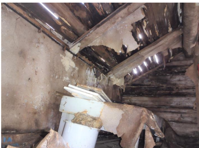
37-38. Vesikatto vuotaa/vuotanut (valo paistaa) pihapään huonetilan parviosalla, puoissa lahovikoja, jiiri romahtamassa
