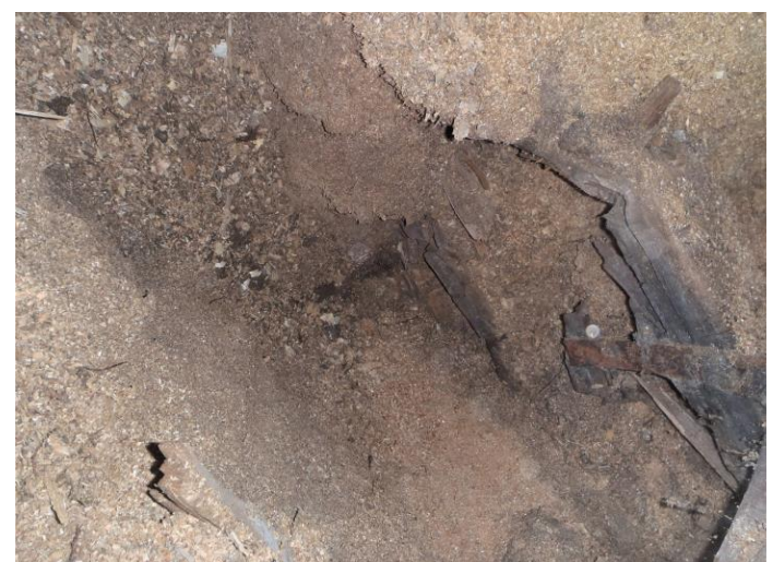
9-10. Ulkoseinäyläosissa/yläpohjassa pihisivulla (ent k/oh-et:n vuotkohdat) vanhoja kosteusvaurioita (kattohuopa uusittu)
