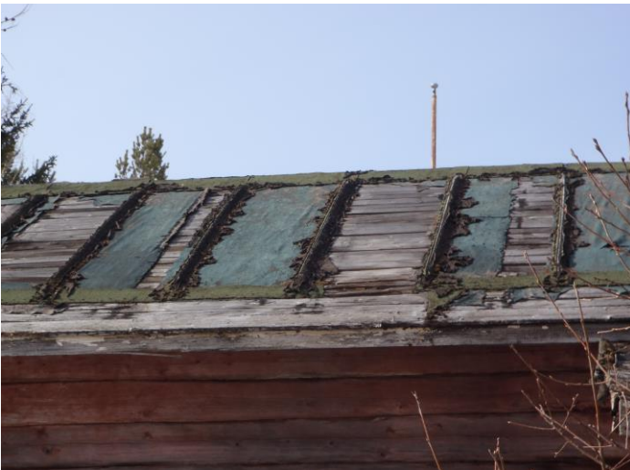
43-44. Talousrakennuksen vesikaton huopakate osin puuttuu, laudoituksessa/räystäässä lahojikoja. Sadevesipoistoja ei ole ollut
