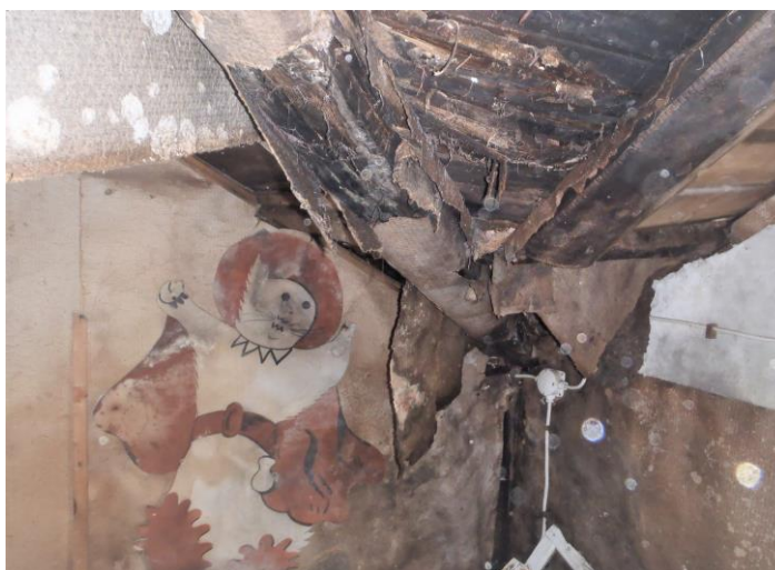
37-38. Vesikatto vuotaa/vuotanut (valo paistaa) pihapään huonetilan parviosalla, puoissa lahovikoja, jiiri romahtamassa
