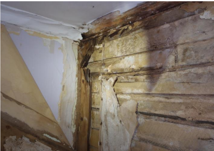
49-50. Päärakennuksen huoneseinien ja -kattojen pintamateriaalien alla paikoin vanhoja vuotojälkiä ja -vikoja.
