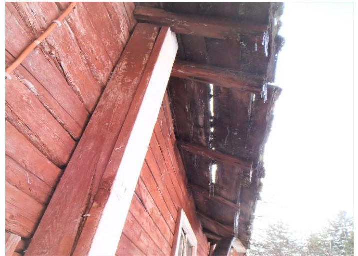
43-44. Talousrakennuksen vesikaton huopakate osin puuttuu, laudoituksessa/räystäässä lahojikoja. Sadevesipoistoja ei ole ollut
