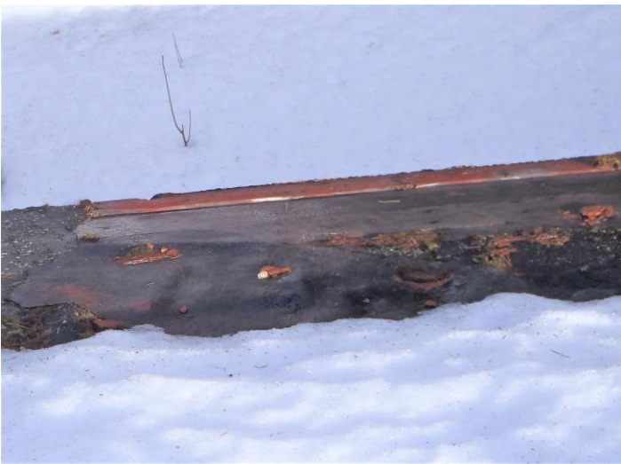
25-26.Vesikaton kattuhuopa heikkokuntoinen takalappeella(pihalappeella korjattu).Yksi piipuista romahtanut
